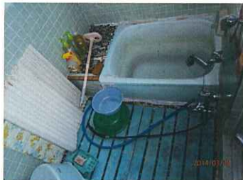
浴槽が深く寒い浴室
